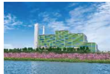
安徽六安环保发电厂(1200吨/天)
