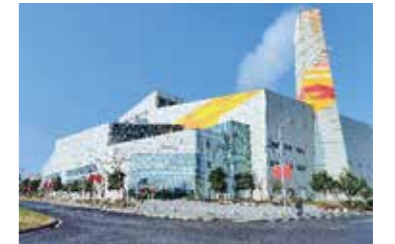
浙江绍兴环保发电厂(2250吨/天)
