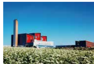
内蒙古赤峰环保发电厂(800吨/天)
