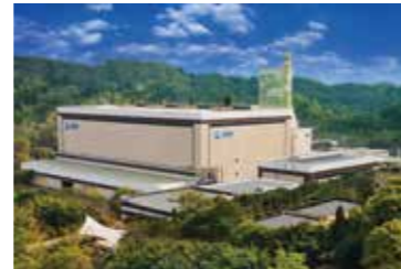
重庆丰盛环保发电厂(2400吨/天)
