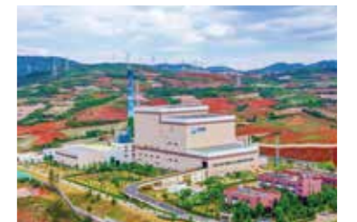
昆明三峰环保发电厂(1000吨/天)
