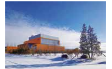
辽宁鞍山环保发电厂(1500吨/天)
