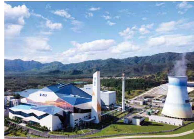
服务粤港澳大湾区·广东汕尾环保发电厂(2100吨/天)
