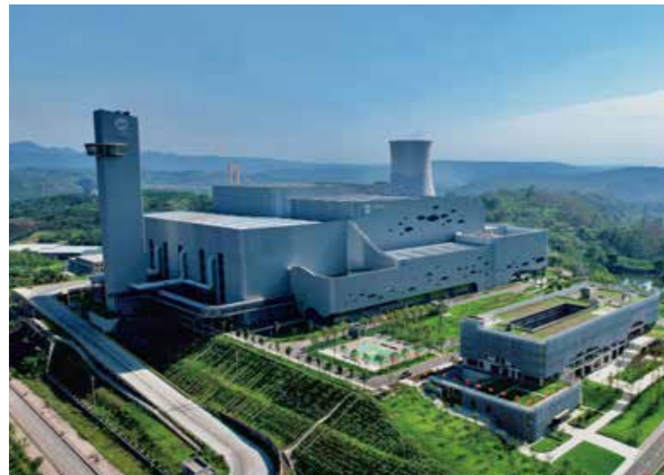
超低排放·重庆御临环保发电厂(3000吨/天)
