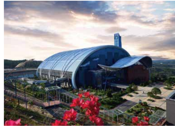
辐射东盟·南宁三峰环保发电厂(2000吨/天)
